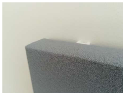
Kunststoffkeil von oben zwischen Wand und Paneel schieben
